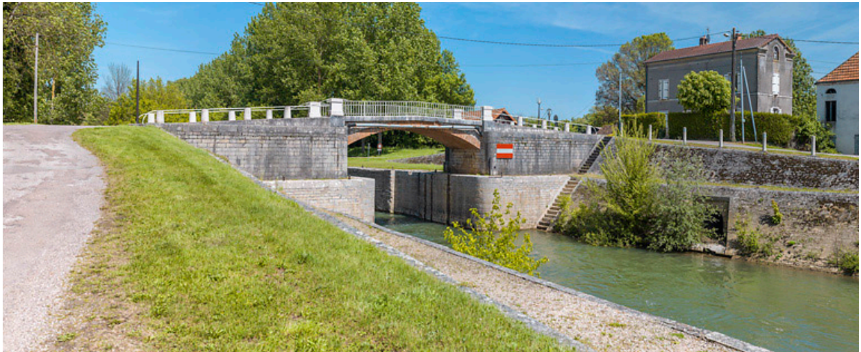
Vue d'ensemble du pont sur écluse, d'aval. A droite, la maison éclusière.
