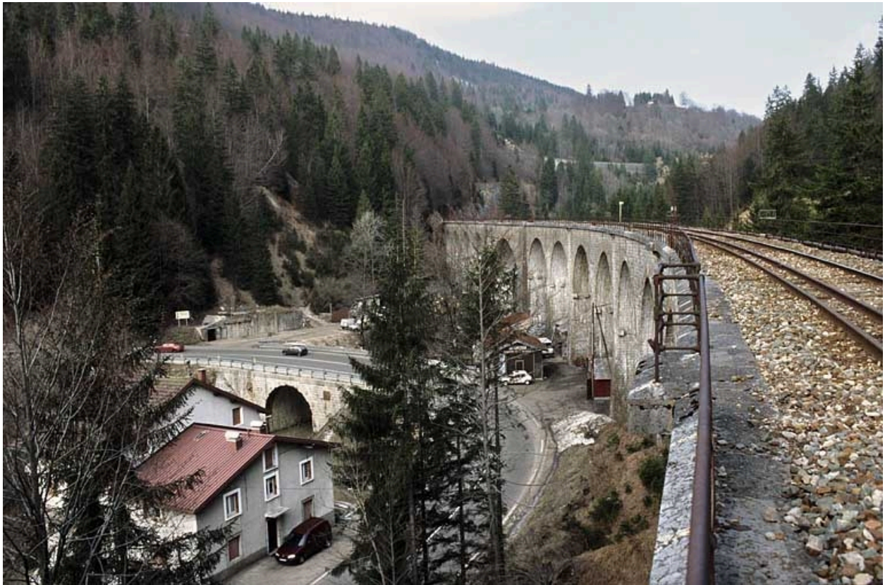
Elévation occidentale vue en enfilade, depuis le sud-ouest (côté La Cluse).
