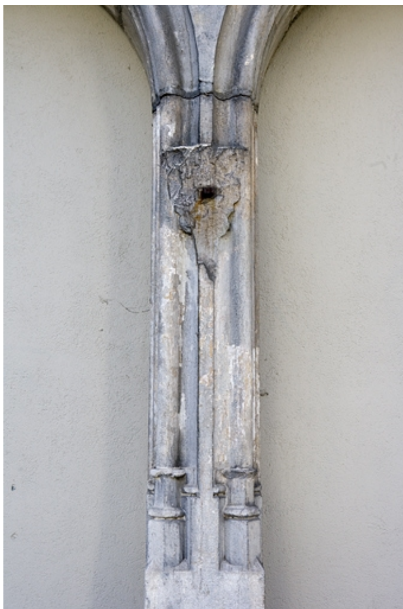
Détail du pilier central de l'ancien portail d'entrée de l'église du couvent des Carmes.
