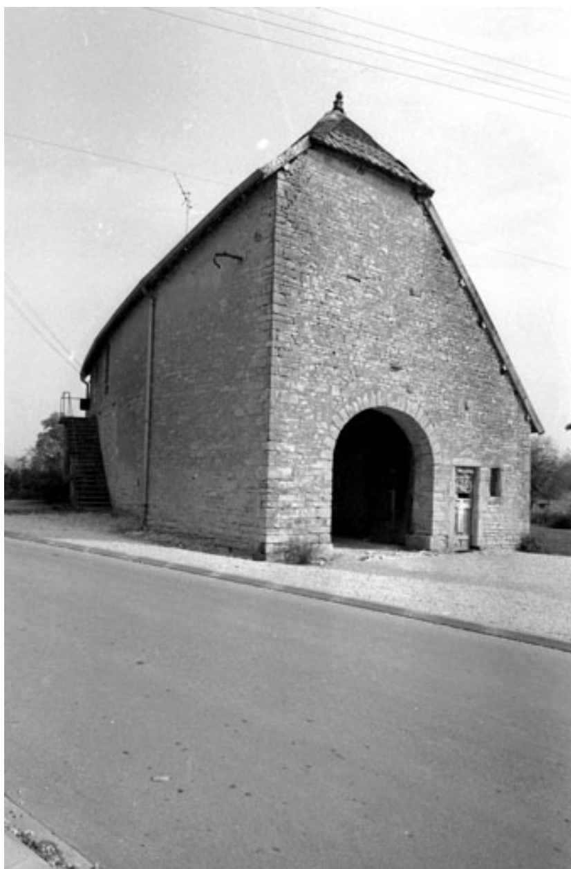
Façades antérieure et latérale droite.
