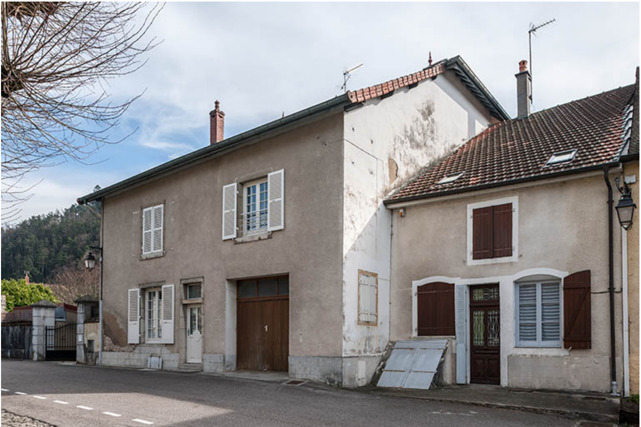
Angle nord-ouest de la façade sur rue de la maison de fonction, 9 place Notre Dame.
