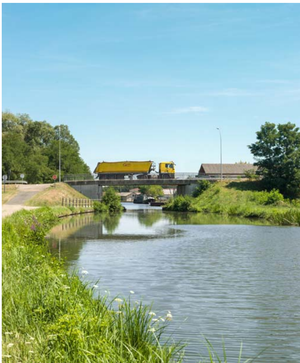
Vue générale du pont.
