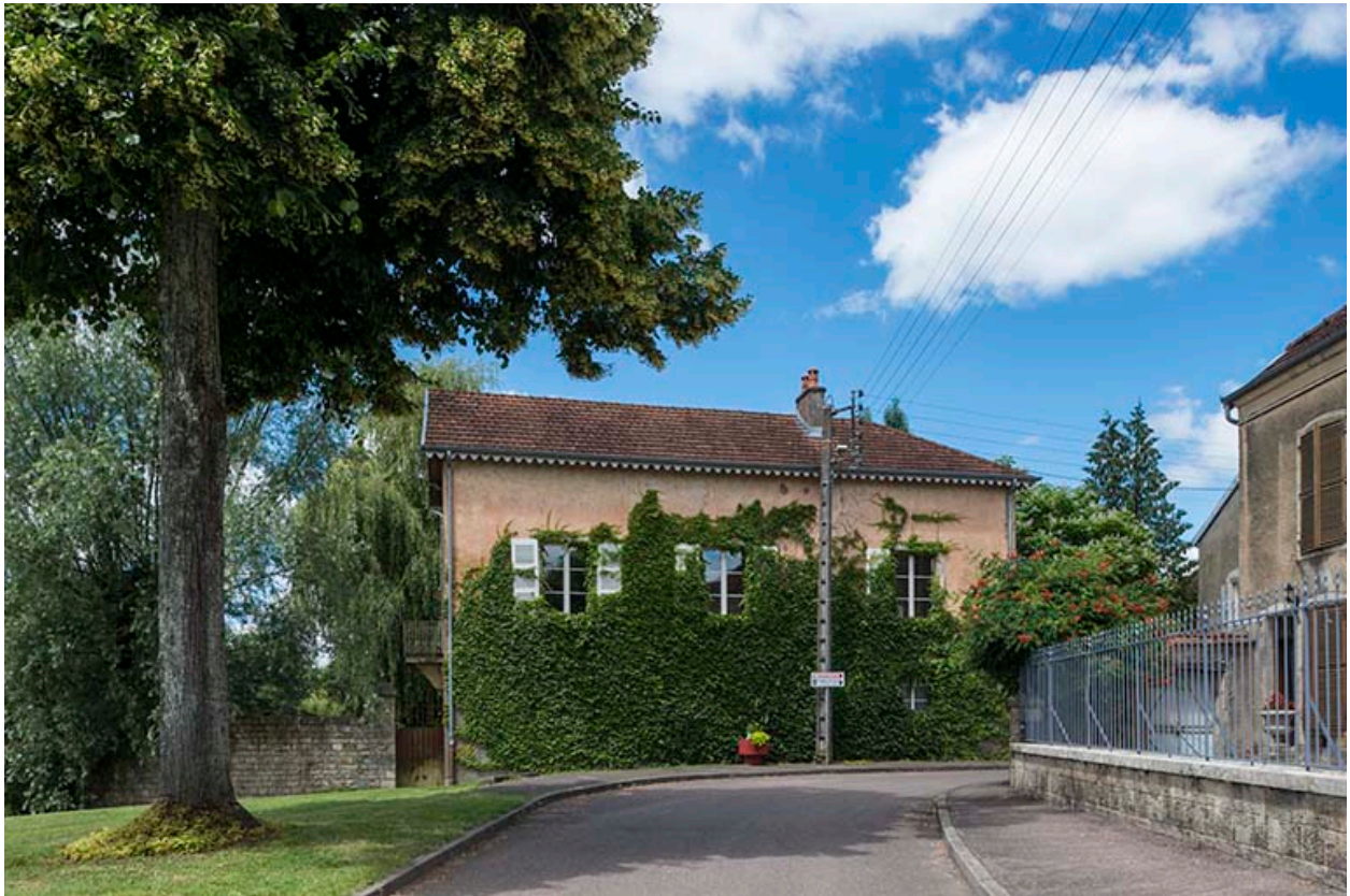
Ancienne tannerie, grande rue du Bourg.
