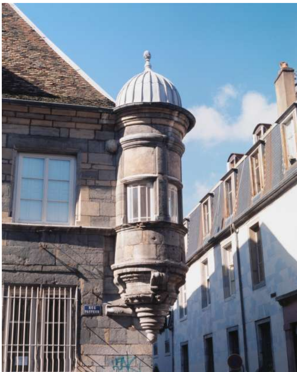
Façade latérale gauche : vue d'ensemble.
