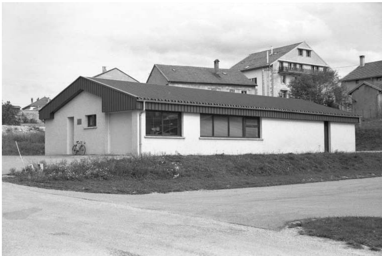
La nouvelle usine (rue Lacuzon).
