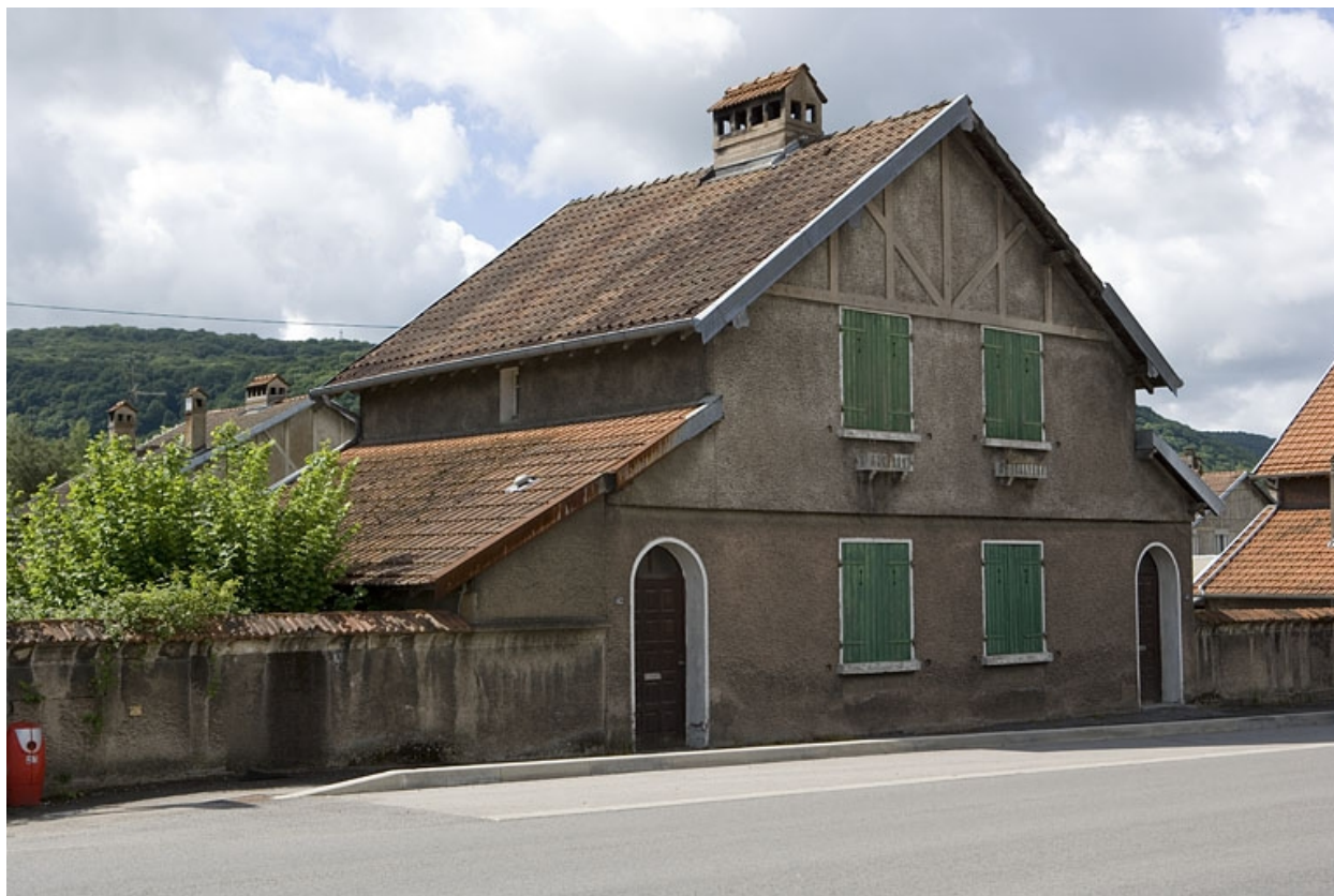
Cité Lehmann. Façade antérieure d'une maison.
