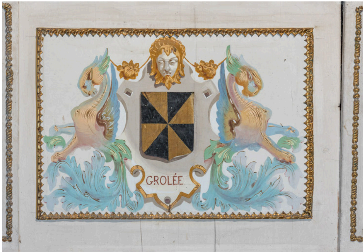
Garde-corps : armoiries de la famille de Grolée.
