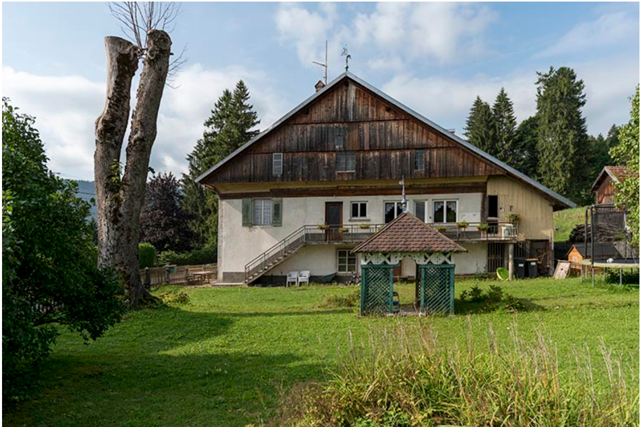
Façade latérale droite.
