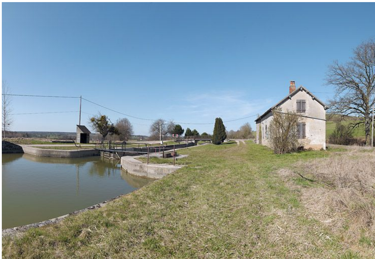
Le site d'écluse vu d'amont.
