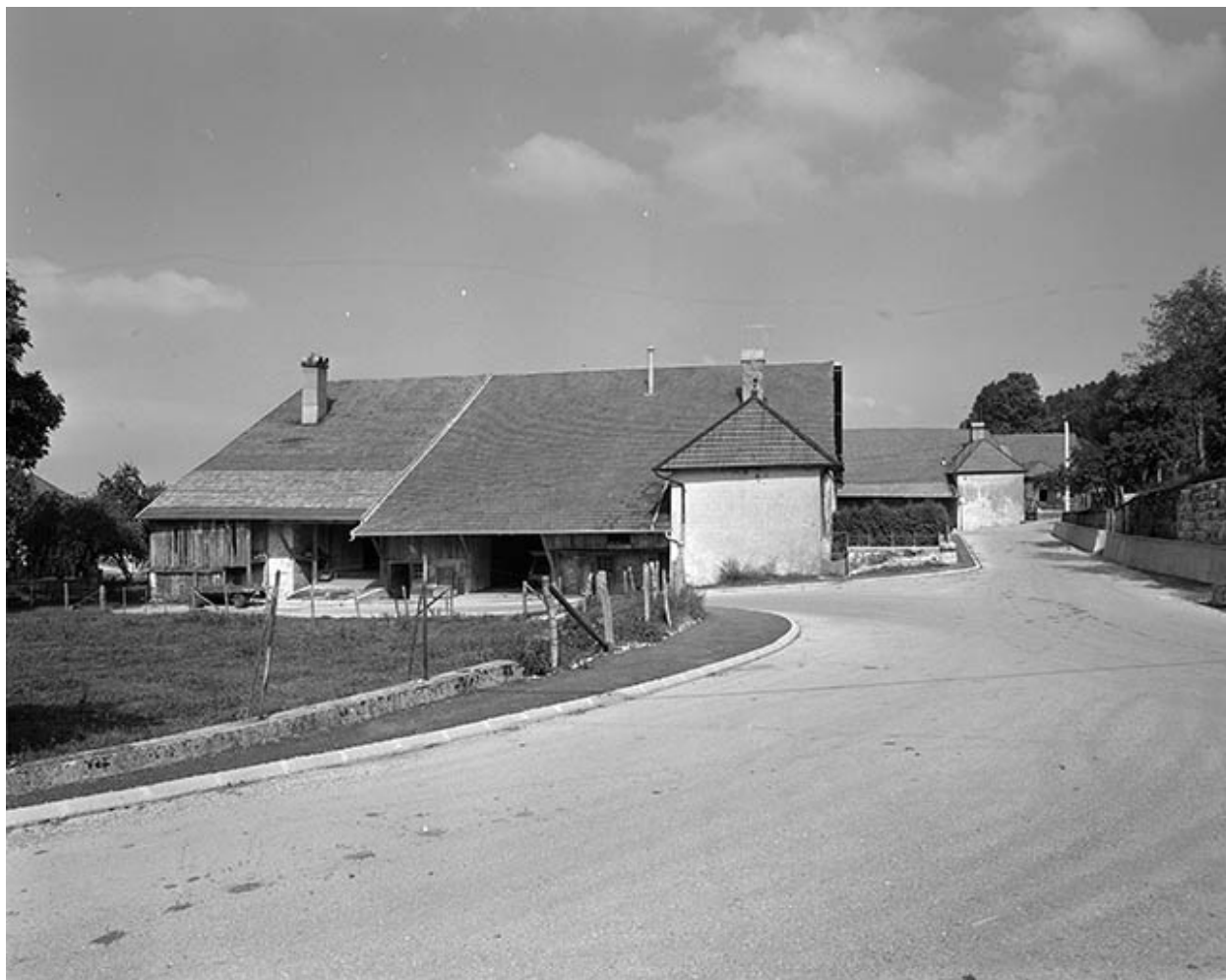
Vue d'ensemble des fermes.
