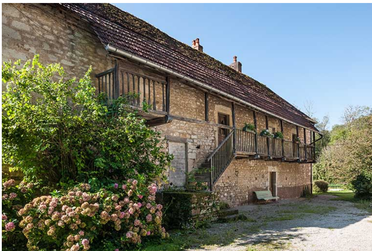
Façade nord du logement patronal.
