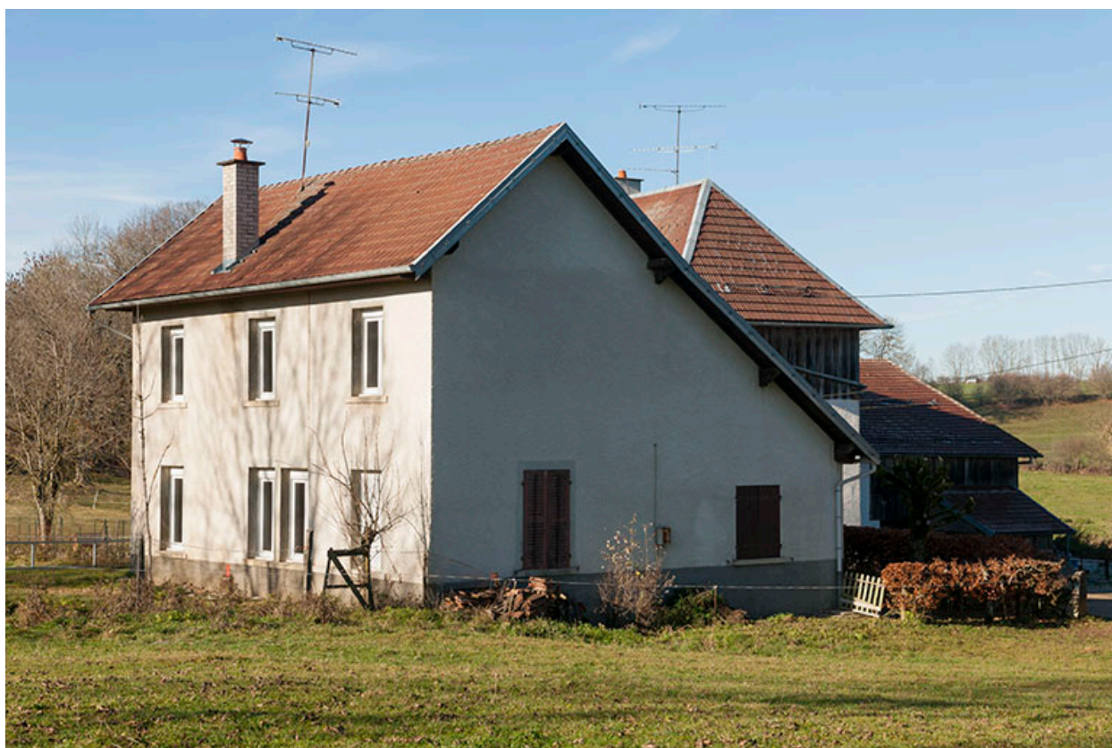
Atelier : façades sud et est. L'ancienne fenêtre multiple est visible au rez-de-chaussée.
