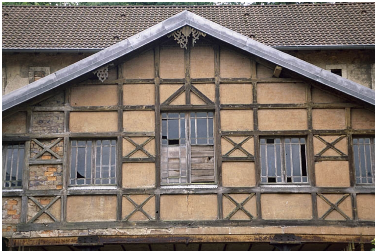
Détail du pignon de l'écurie.
