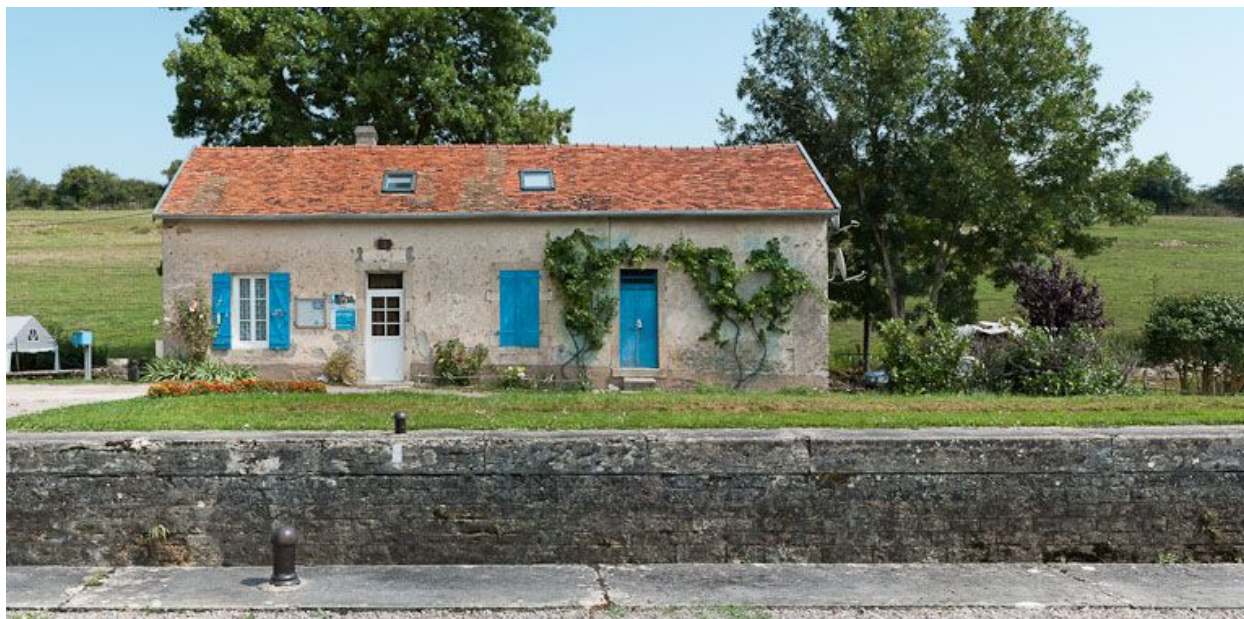
Vue de face de la maison éclusière.
