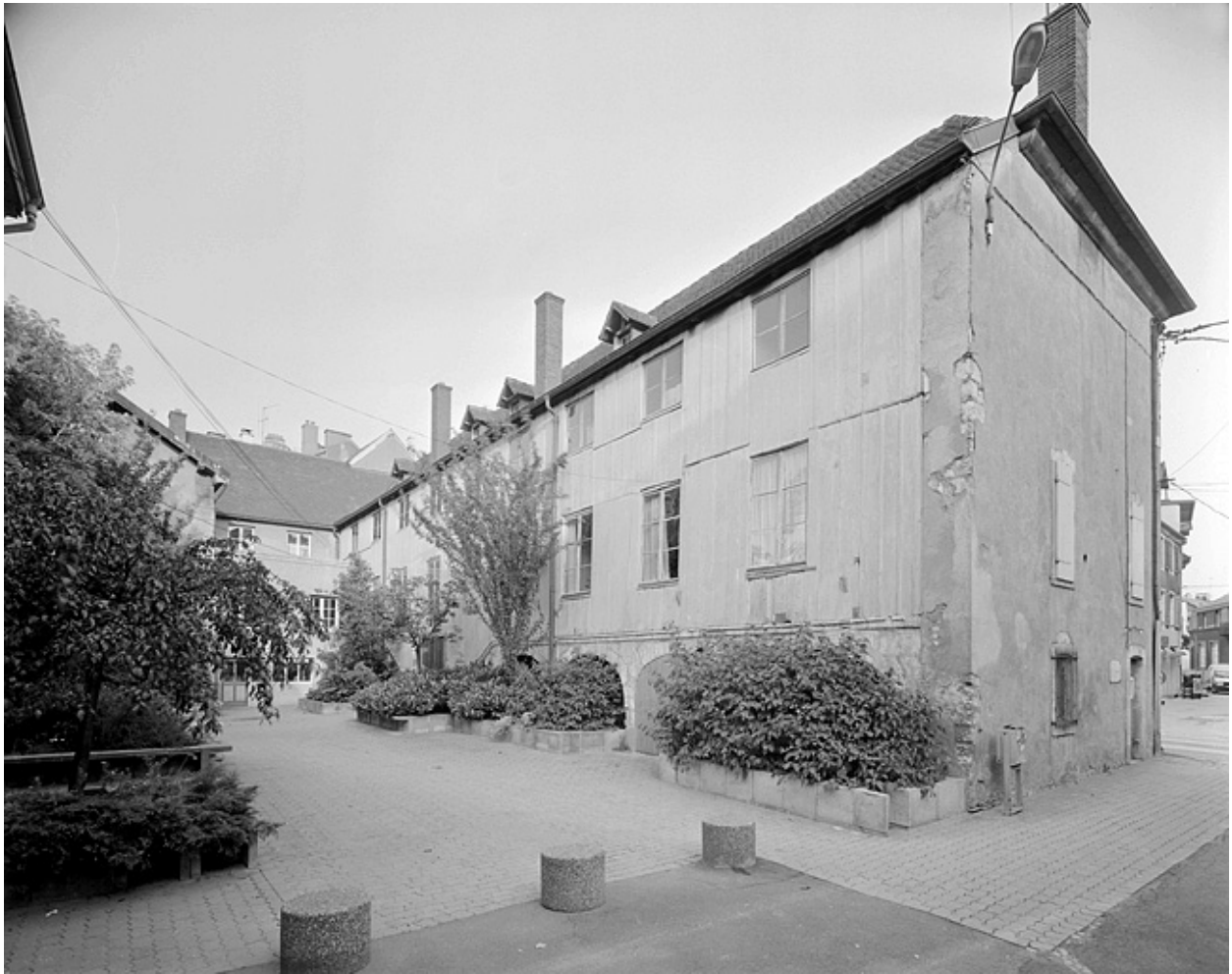
Façade sur cour.
