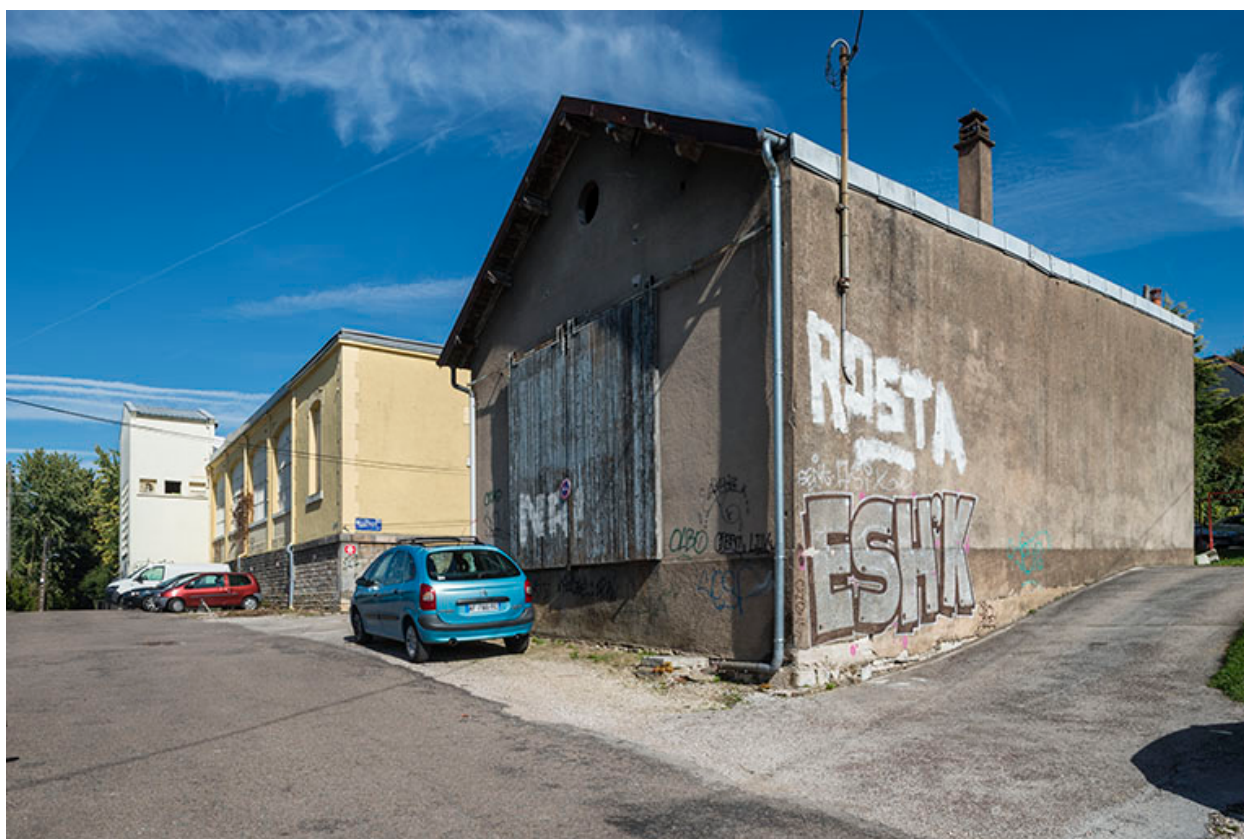
Façade ouest des ateliers.
