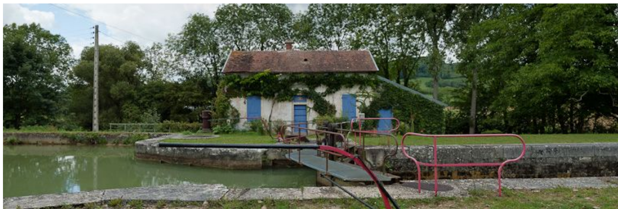
Vue de face de la maison éclusière.
