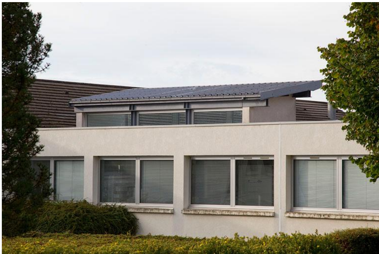
Lanterneau sur l'extension nord.
