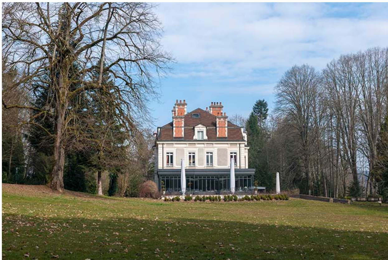
Logement patronal. Façade sud depuis le parc.
