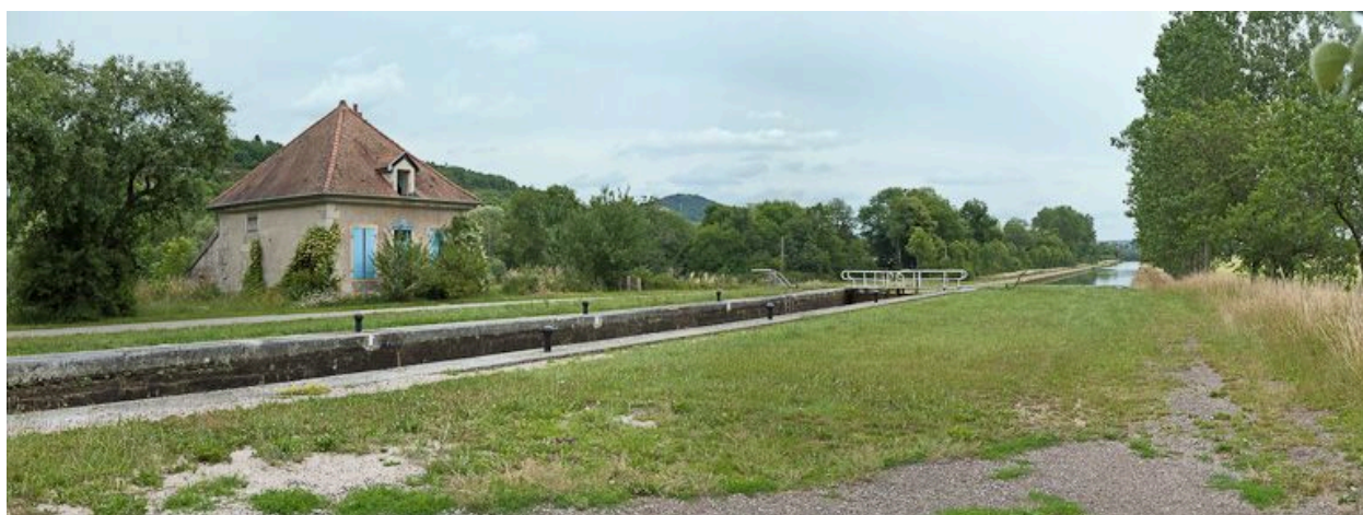
Vue d'ensemble du site d'écluse.
