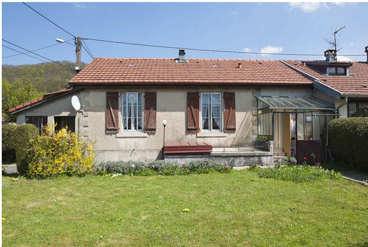
Façade postérieure d'une maison individuelle.
