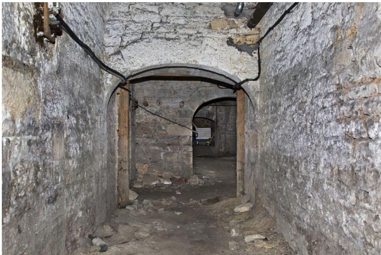
Sous-sol : détail d'un passage.
