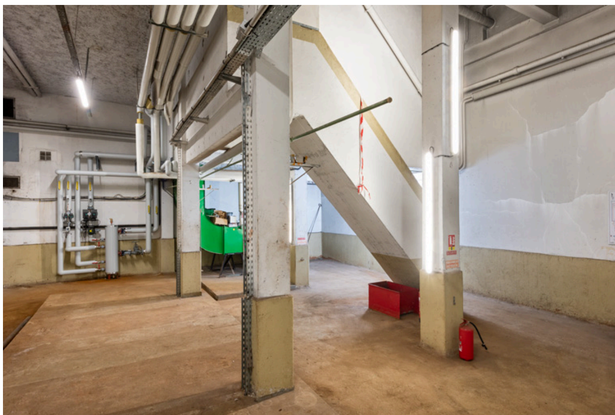
Maison de la culture : ancienne chaufferie côté RN (étage de soubassement).
