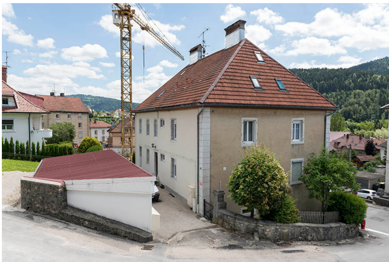
Façades postérieure et latérale gauche.
