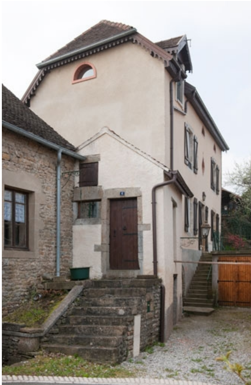
Habitation : façade latérale gauche et façade antérieure.
