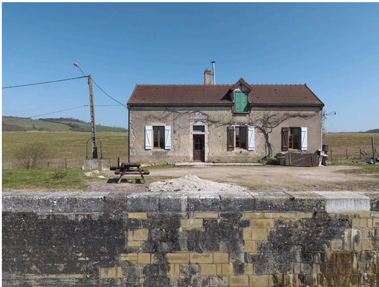
La maison éclusière de face. Puits.
