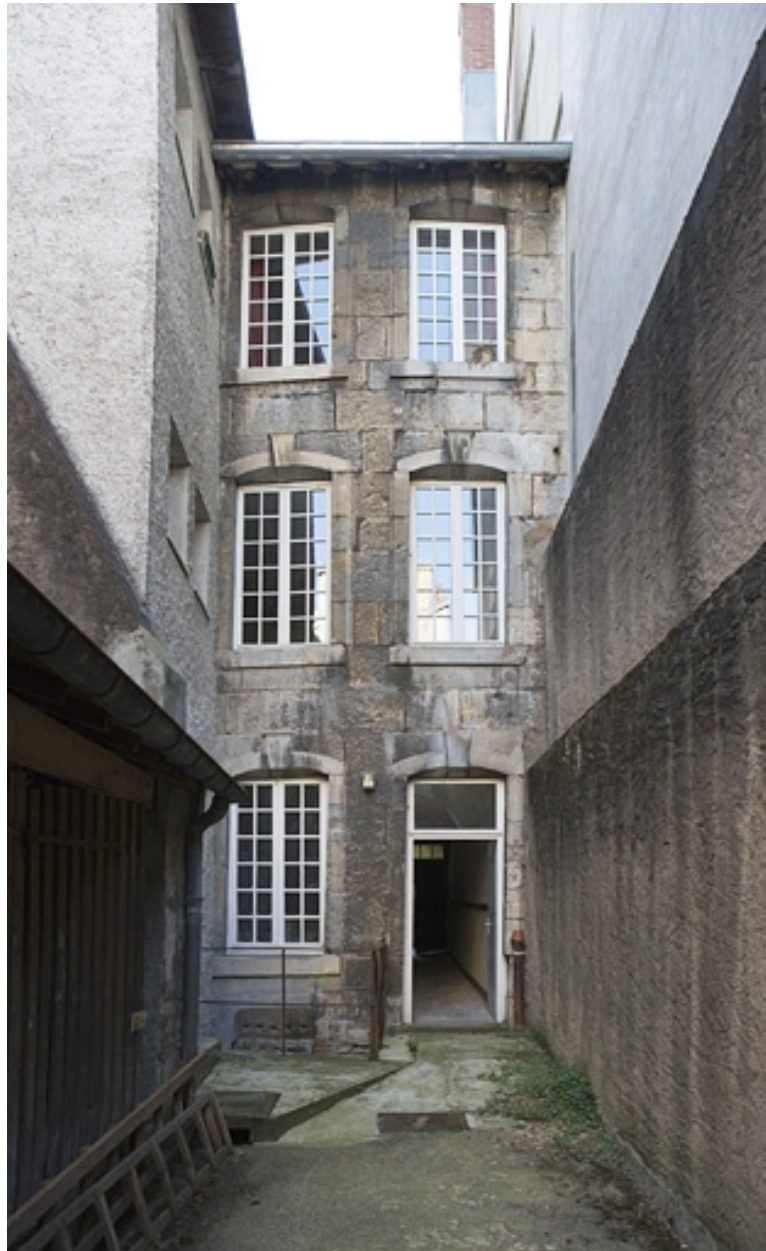
Vue d'ensemble de la façade postérieure du logis secondaire sur la deuxième cour.
