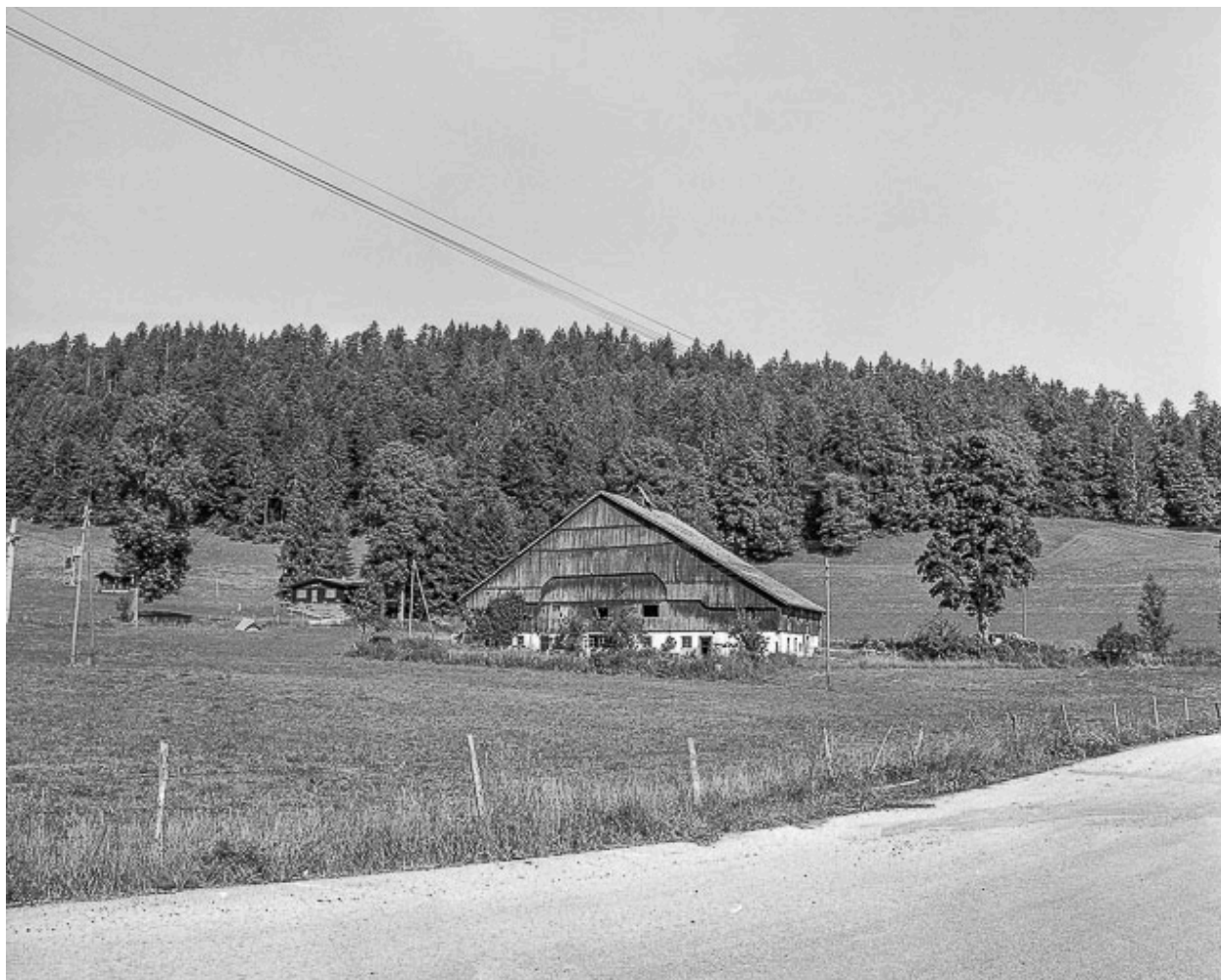
Ferme située au lieu-dit Le Chauffaud : vue d'ensemble.
