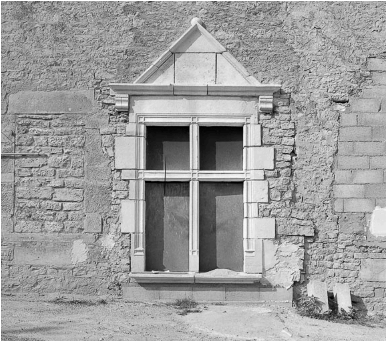
Détail d'une fenêtre restaurée de l'habitation.
