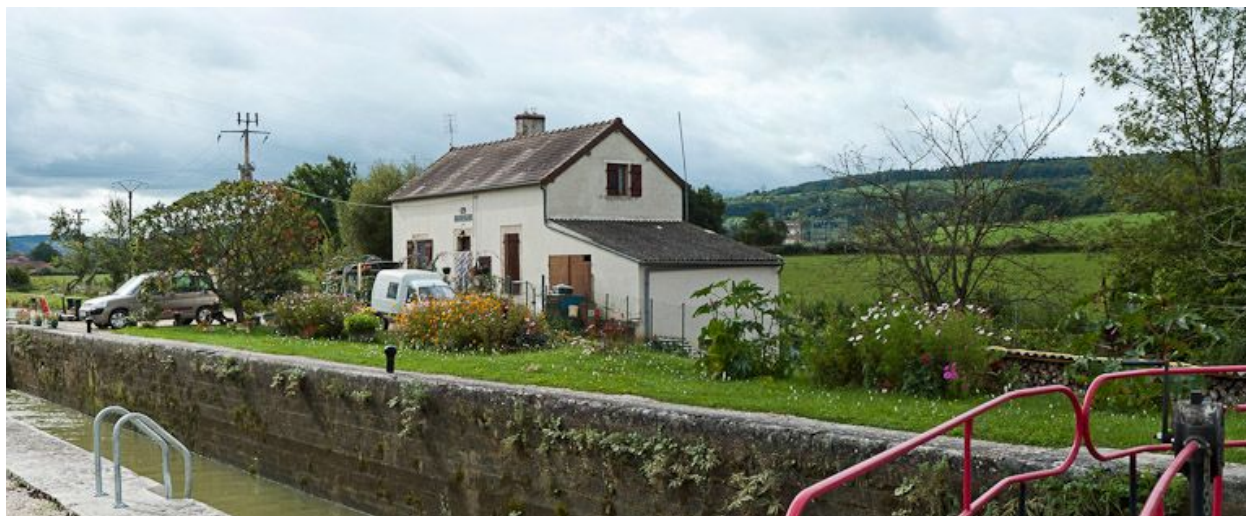
Vue d'ensemble du site d'écluse.
