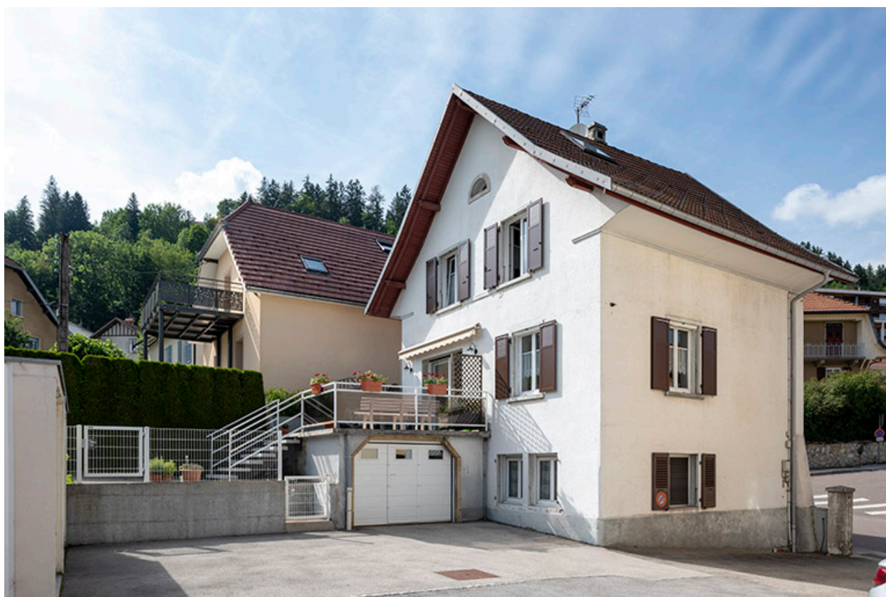
Façades postérieure et latérale gauche.
