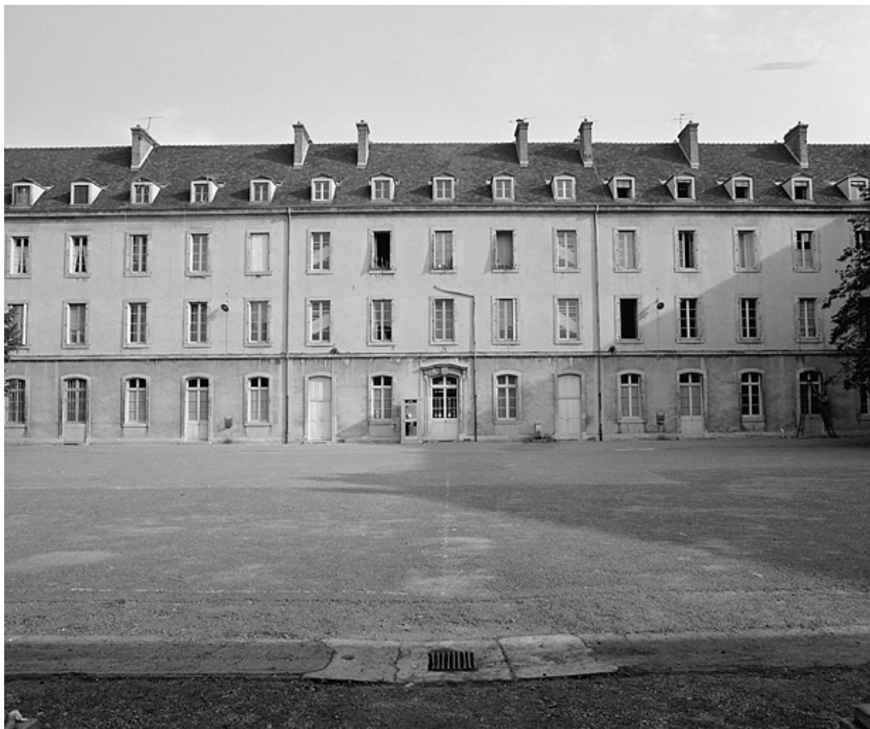
Façade postérieure sur la cour.
