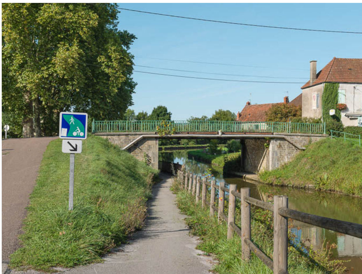
Vue d'ensemble du pont.
