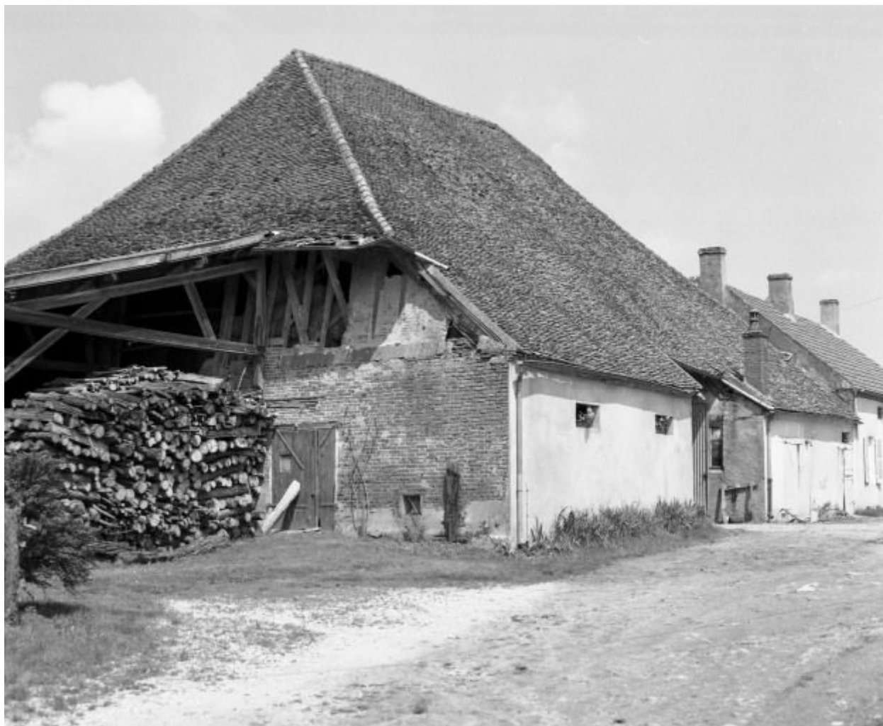
Vue d'ensemble d'une ferme (cad. 1981, sect. B2, parc. 265-268).
