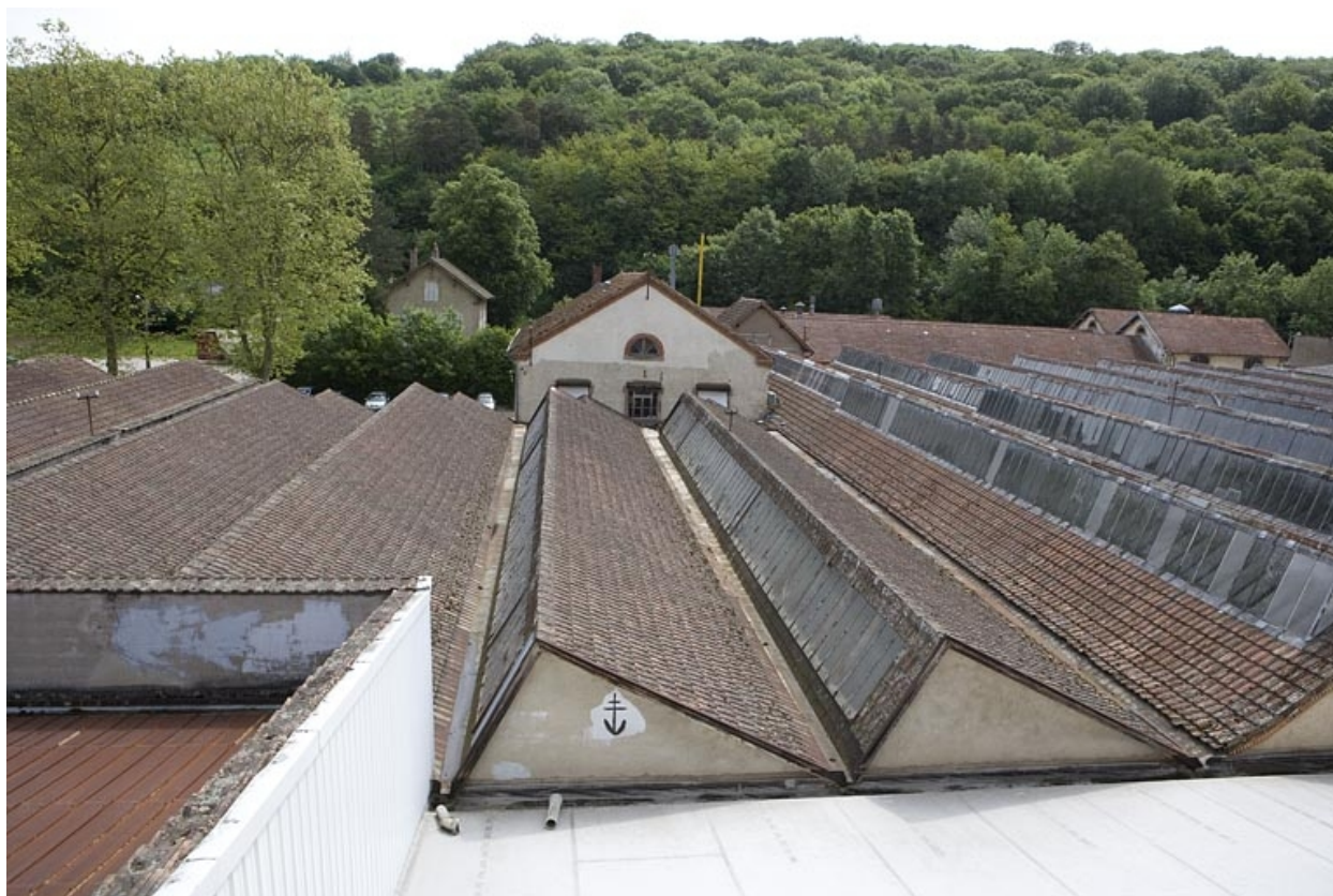
Magasin industriel. Vue de face d'un shed.
