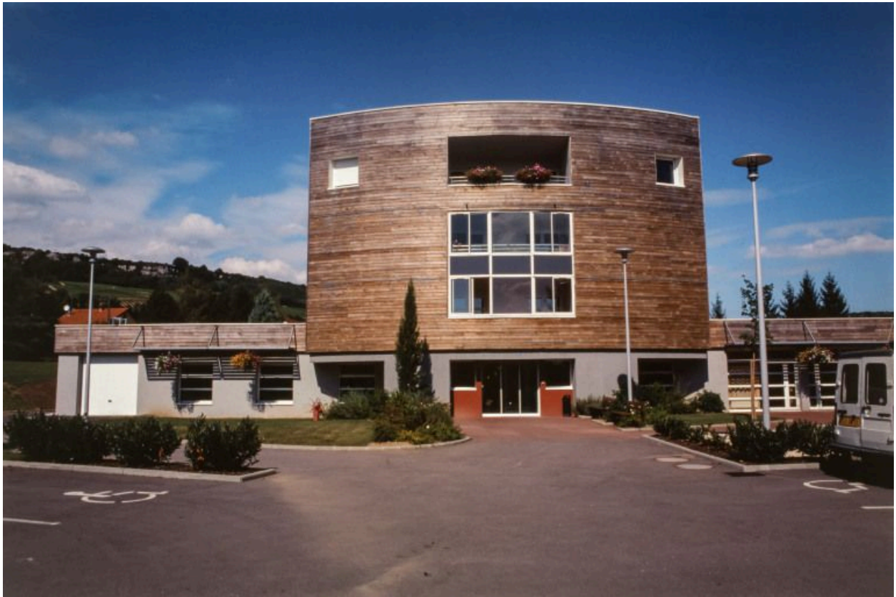
Maison de retraite, élévation antérieure.
