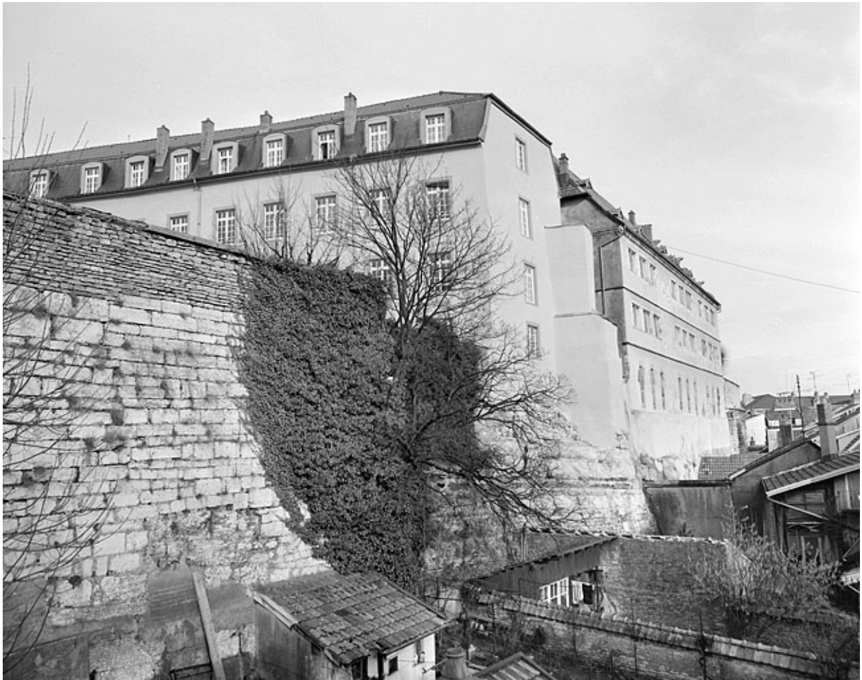
Enceinte. Partie sous le Vieux Château (k).
