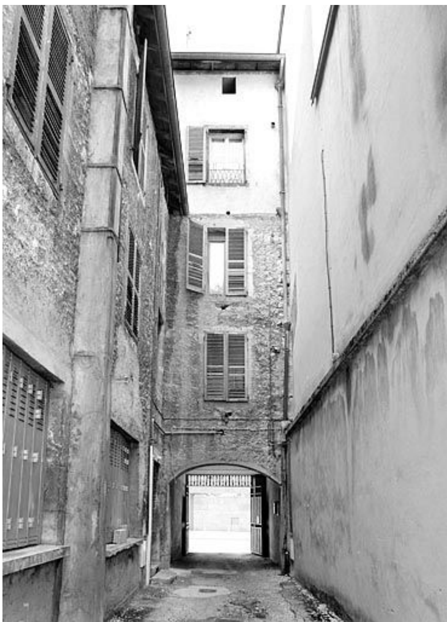
Façade postérieure du n° 141 et passage.
