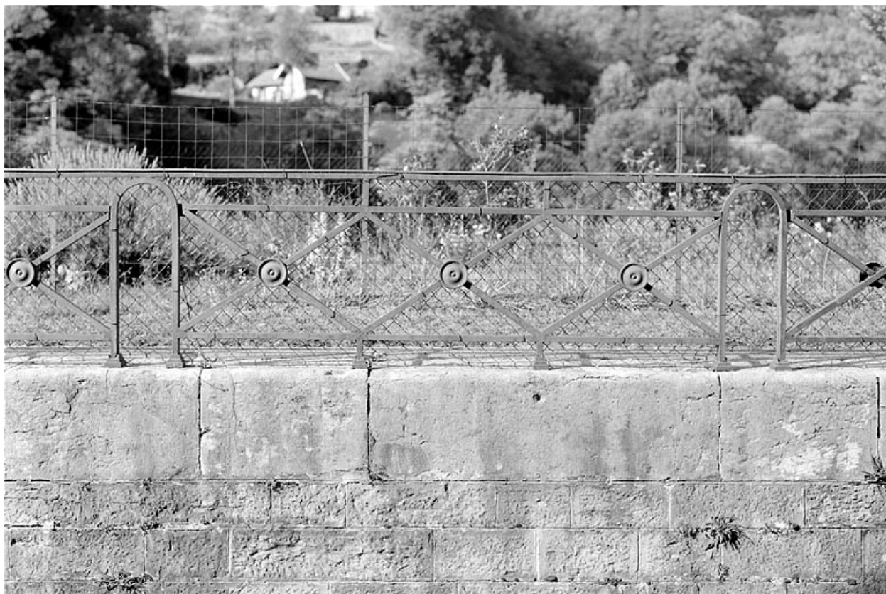
Garde-corps métallique, vu de face.
