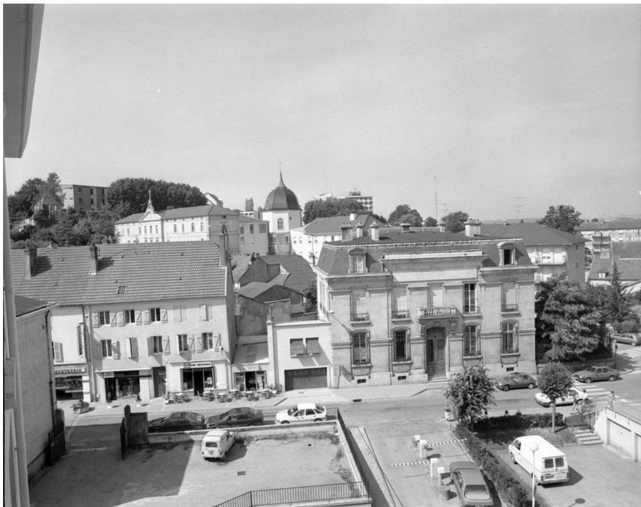
Vue d'ensemble éloignée.
