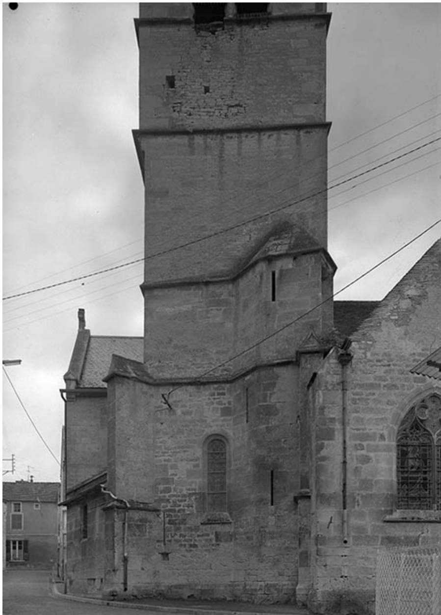
Base du clocher côté nord, entre transept et chevet.
