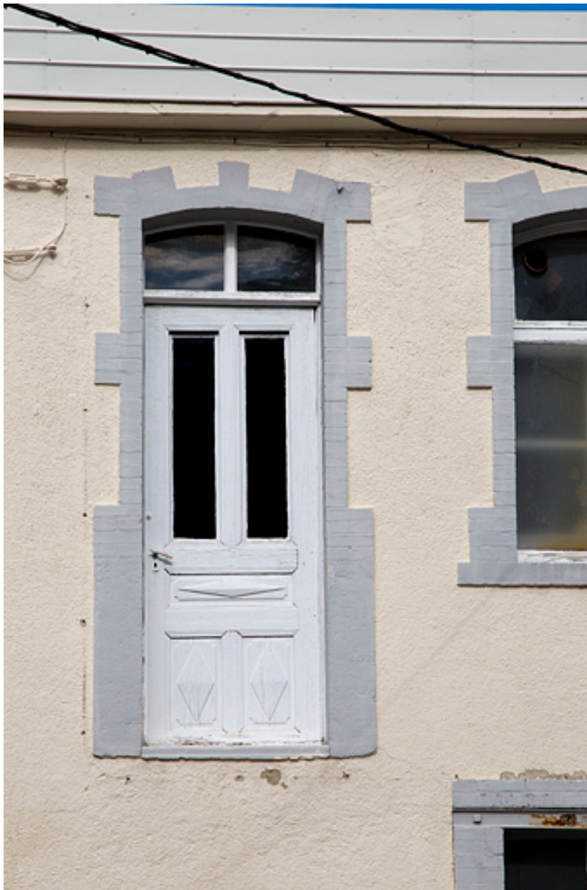
Atelier rehaussé en 1923-1924 : porte haute.
