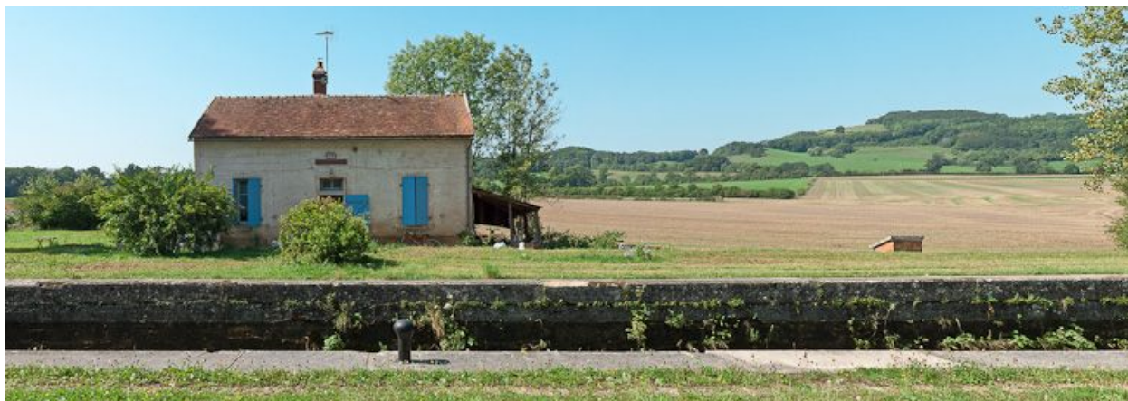
Vue de face de la maison éclusière.
