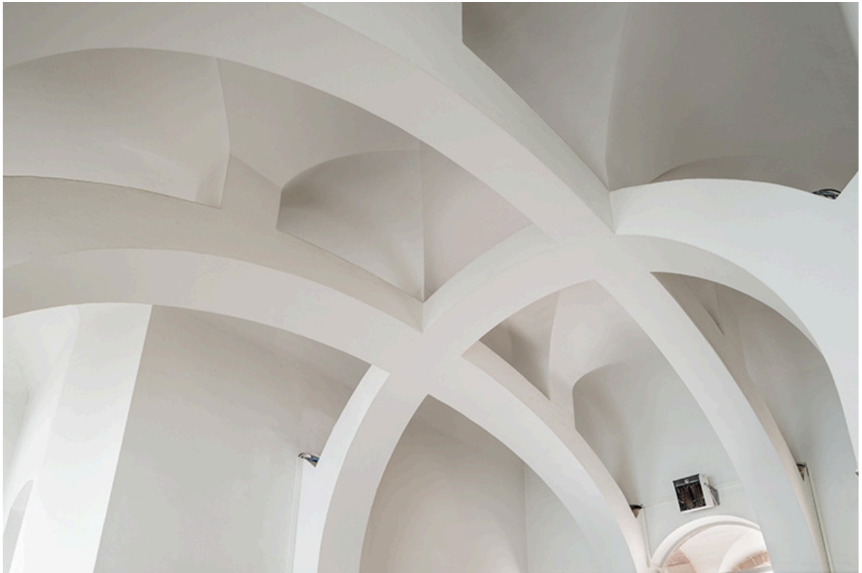
Vestibule nord à l'emplacement du Bain des Cuvettes, voûte.
