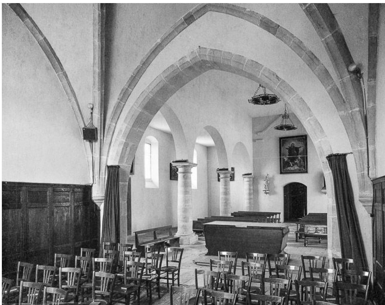
Intérieur : élévation droite de la nef.
