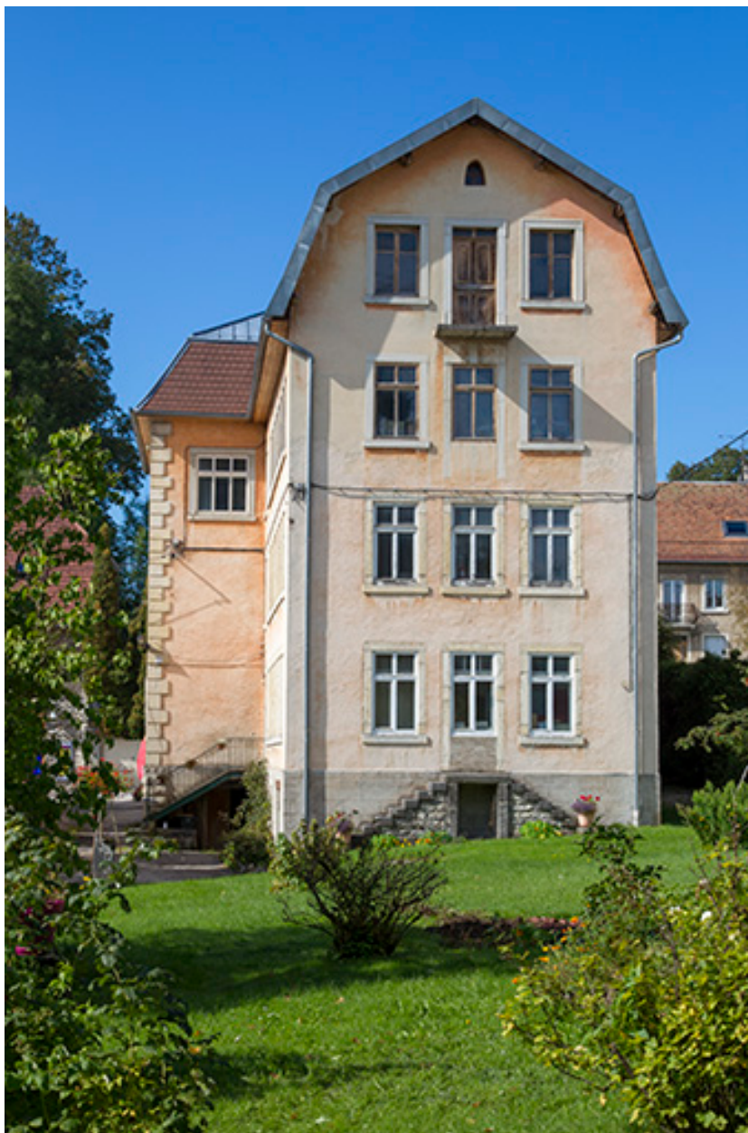
Usine : façade latérale droite.
